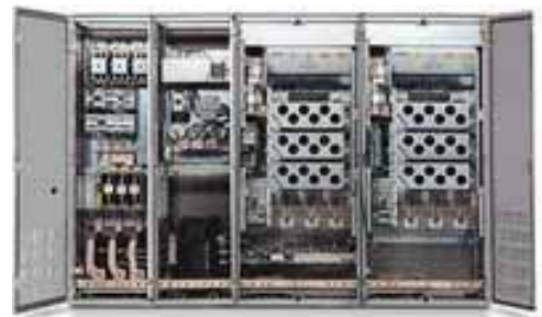
รูปที่ 11 แสดงลักษณะแวงจรภาคกำลัง ของเรกติไฟร์เออร์แบบ AFE
